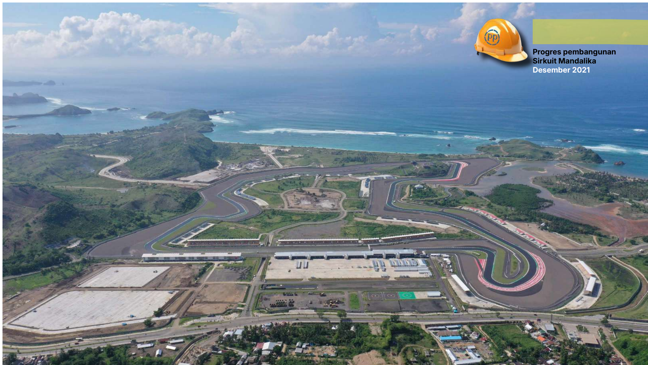
Foto-foto: Progres pembangunan Sirkuit Mandalika (Sumber: Dokumentasi PT Pembangunan Perumahan)
