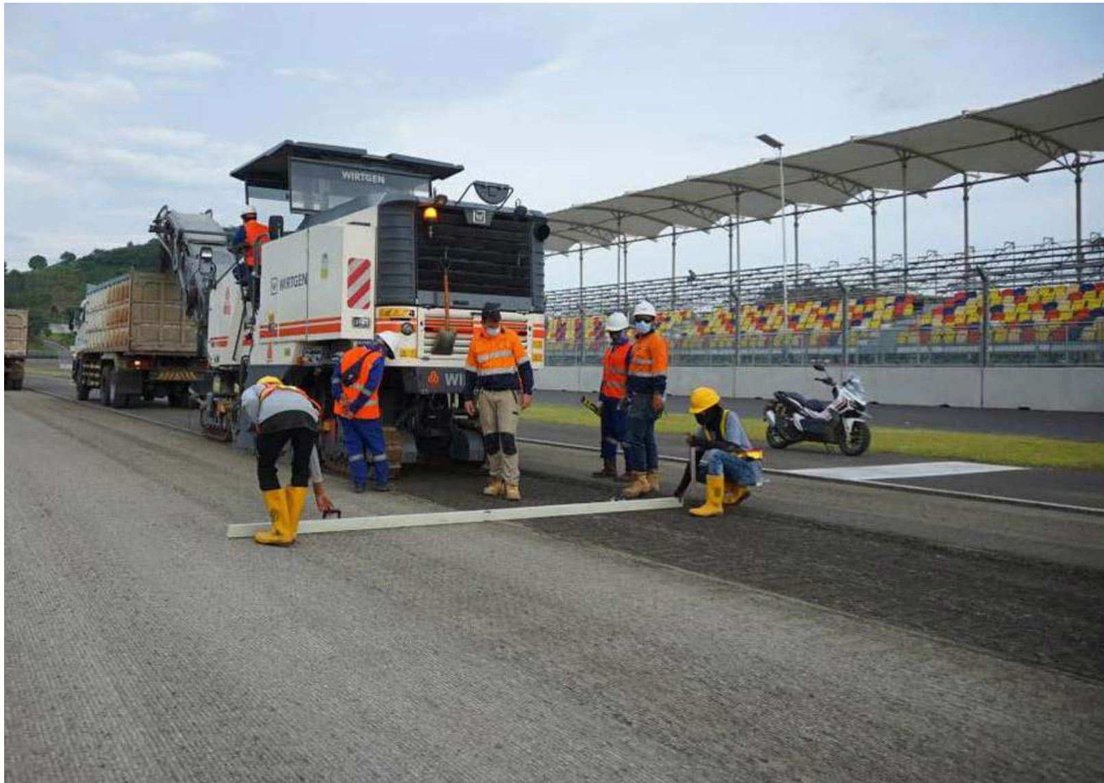
Foto: Pengaspalan ulang Sirkuit Mandalika jelang gelaran MotoGP 2022. Pengaspalan ulang diperlukan karena saat tes pra musim pada 11-13 Februari 2022, sebagian aspal lintasan mengelupas. (Dok. PTPP)
