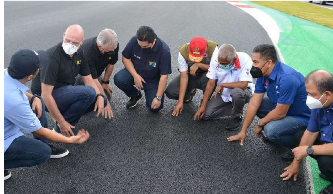
Foto: Pengaspalan ulang Sirkuit Mandalika jelang gelaran MotoGP 2022 (Dokumentasi PT Pembangunan Perumahan)
