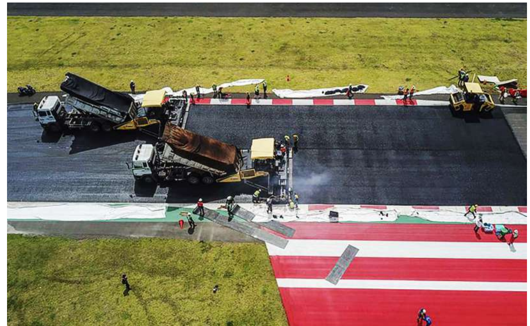
Foto-foto: Pengaspalan ulang main track Sirkuit Mandalika menggunakan Stone Mastic Asphalt (SMA) sepanjang 1,2 km pada tikungan 17 sampai dengan tikungan 5.
