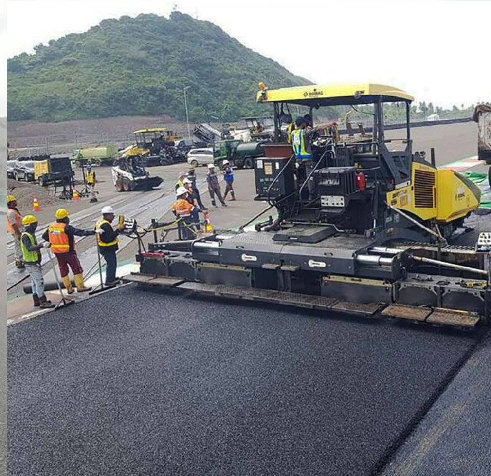
Foto-foto: Pengaspalan ulang jelang gelaran MotoGP Mandalika 2022. Pekerjaan resurfacing diselesaikan PT PP Presisi dalam 5 hari (5 Maret-9 Maret 2022). PP Presisi memberikan dukungan resurfacing dengan mengerahkan alat berat yakni tiga unit asphalt finisher , enam unit vibro tandem roller , asphalt distributor dan dua unit pneumatic tired roller .
